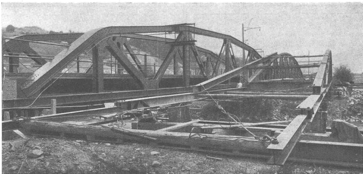
Thurbrücke Ulisbach SBB-Strecke Wattwil-Nesslau
