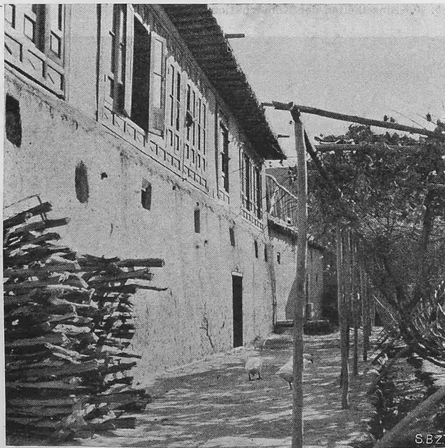
Abb. 3. Aelteres Landhaus bei Kabul. Untergeschoss mit Lager-räumen und Ställen für die Reitpferde in Stampflehm mit Lehm-Stroh-Putz. Das Obergeschoss als Holz-fachwerk mit Lehmziegeln, geschützt durch das charakteristische Vordach
