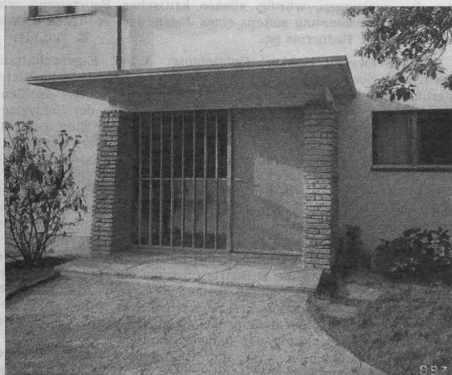
Abb. 11. Entrée mit Haustüre und Glaswand
