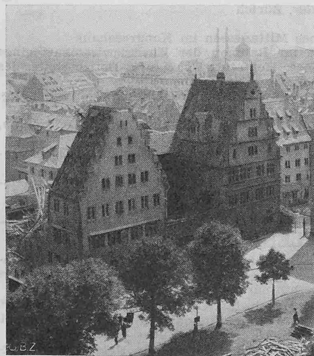
Abb. 3. Frauenhaus vom Münster aus gesehen: Ostflügel teilweise zerstört, Westflügel (mit Renaissancegiebel) erhalten
