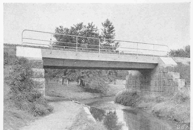
Abb. 12. Eichbachbrücke bei Dotzigen, Stützweite 12,4 m, schief 60°
