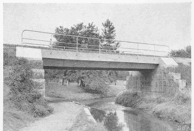
Abb. 12. Eichbachbrücke bei Dotzigen, Stützweite 12,4 m, schief 60°
