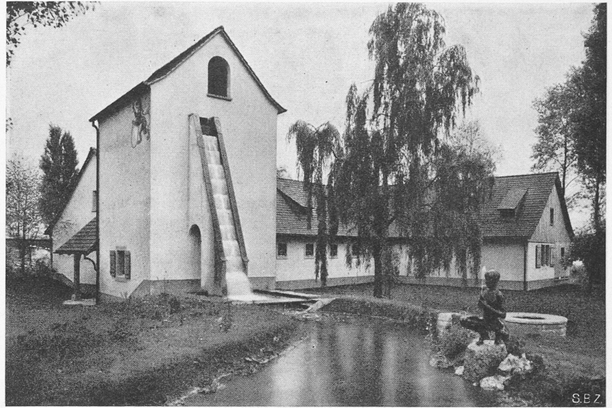
Bild 5. Gesamtansicht der Hochbauten aus Norden
