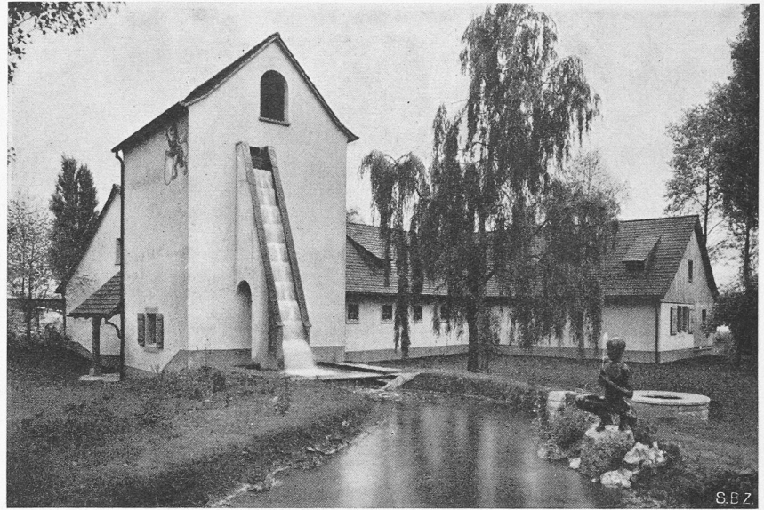
Bild 5. Gesamtansicht der Hochbauten aus Norden
