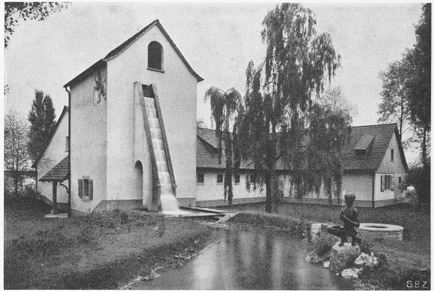
Bild 5. Gesamtansicht der Hochbauten aus Norden
