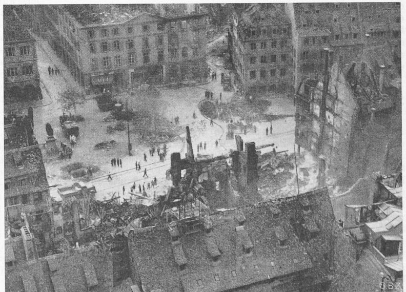
Bild 2. Gutenbergplatz (links Denkmal) nach dem grossen Bombardement vom August 1944, von der Münsterplattform aus nach Süden vorgesehen
