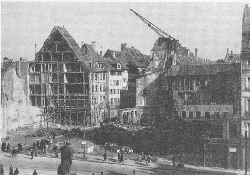
Bild 5. Gutenbergplatz (vorn Denkmal) nach erfolgter Aufräumung im Februar 1945, Blick nach Norden
