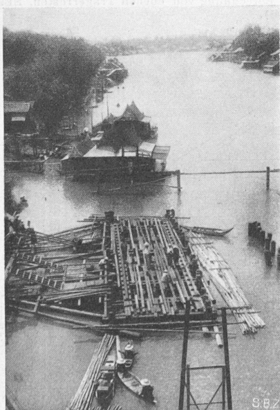
Bild 10. Provisorischer Boden für den Brunnen um Pfeiler C
