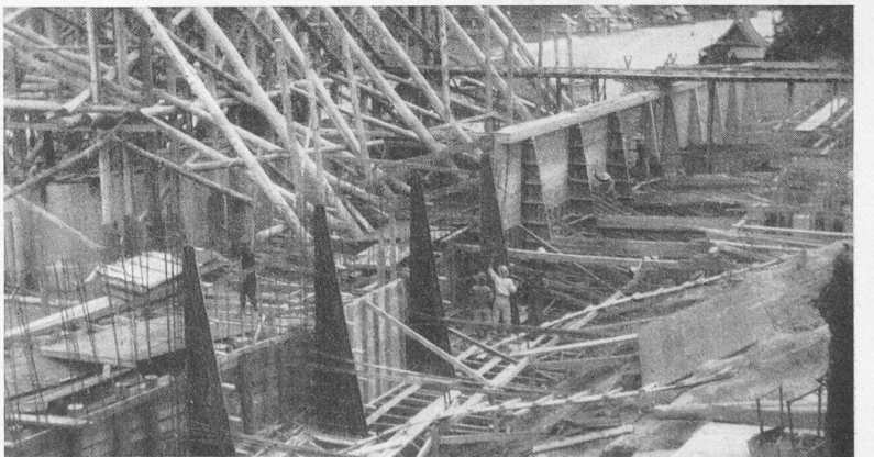
Bild 8. Stützmauer Westufer im Bau, links Pfeiler D
