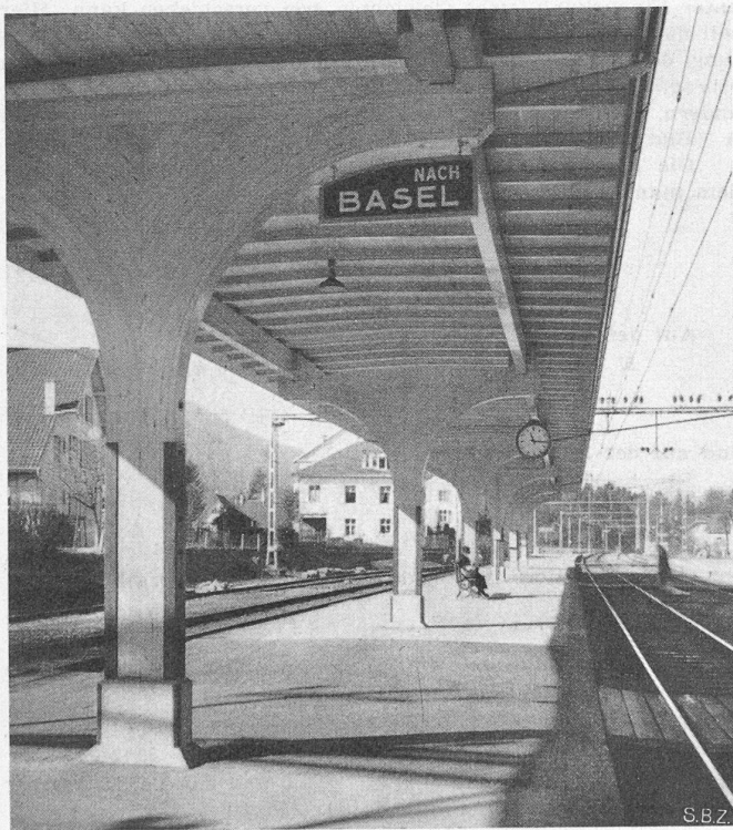
Bild 10. Perrondach in Sissach, Ansicht von unten
