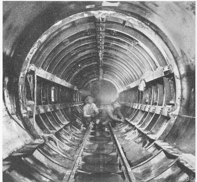
Bild 20. Blaw-Knox Stahlschalung in einem Stollen des Bouquet-Reservoir in Kalifornien
