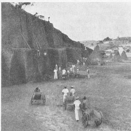
Fig. 3 (en bas). Correction de la ligne à 6 km de Vitoria. Terre-plein de la nouvelle station. Travail manuel
