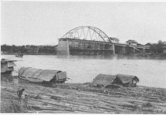
Bild 33 und 34. Erste Hauptöffnung der Brücke in Nakhon Sawan nach dem Hochpressen der Fahrbahn
