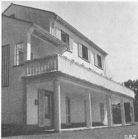
Bild 1. Südlicher Flügel aus Südwest
