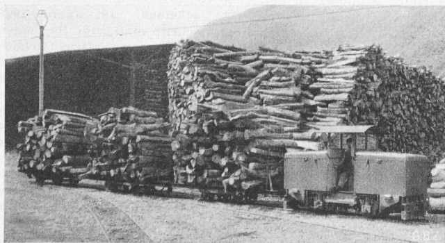
Bild 3. Holztransport mit Akkumulatorenlokomotive
