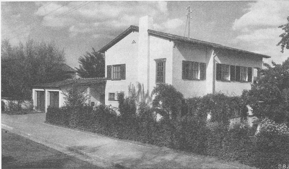
Bild 3. Landhaus in Kilchberg, aus Süden. Arch. ALBERT JENNY, Zürich
