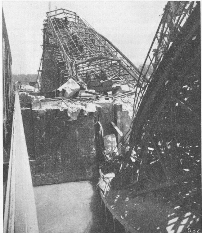
Bild 2. Pfeiler III von der Strassenbrücke aus gesehen: links (hinten) Oeffnung 4, rechts (vorn) Oeffnung 3
