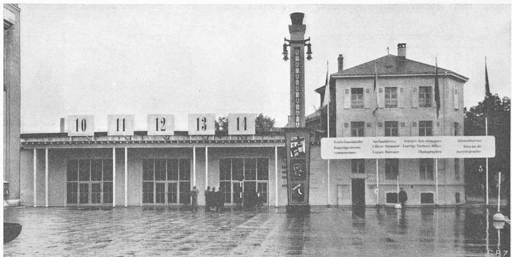
Bild 2. Eingang zu den Hallen X bis XIV (links das Hauptgebäude)
