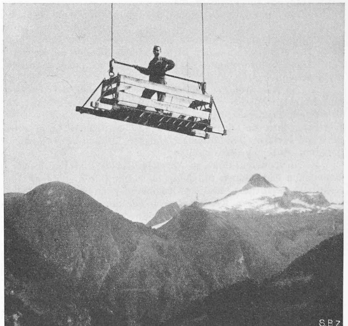
Bild 5. Für Personentransport eingerichtete Kranbrücke, Hubhöhe 60 m
