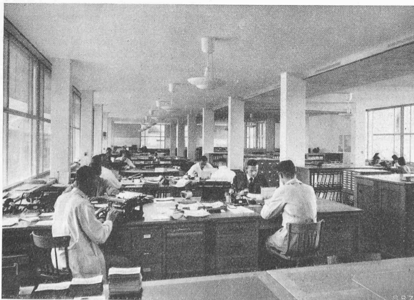
Bild 12. Bureau mit Deckenkühlung und Luftkonditionierung
