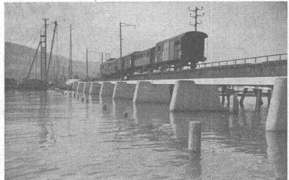
Pfeiler der Eisenbahnbrücke Rapperswil-Hurden
