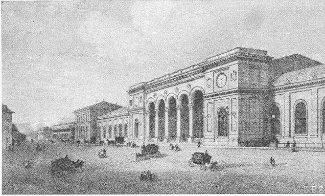
Bild 10. Basel, Centralbahnhof, 1860. Grossartiger, betont grosstädtisch, doch ohne Anmassung und schweizerisches Detail
