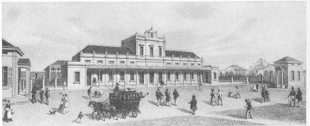
Bild 9. Basel-St. Johann, 1845. Anspruchslos, spätklassizistisch, mit einem Einschlag von Dixhuitième-Eleganz, nicht überinstrumentiert. — Rechts hinten befindet sich das Eisenbahntor, das jede Nacht geschlossen wurde
