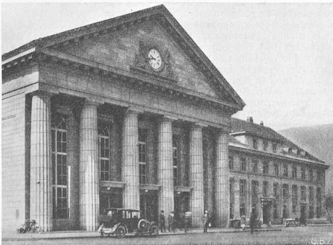
Bild 13. Biel, 1923. Griechische Tempelfront — der Inbegriff statisch-behaltender sakraler Monumentalität, als Kulisse vor einem Durchgangsbahnhof — weit anspruchsvoller, und entsprechend verfehlt als Zürich, Bild 5
