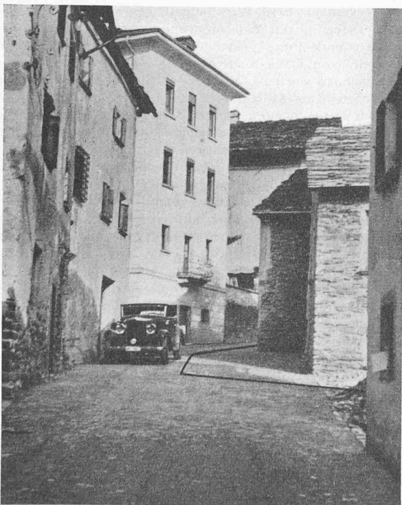
Bild 7. Hauptstrasse in Castasegna (Bergell). Trotz Abbruch eines Hauses (= schwarzer Strich) ist die Dorfstrasse für den Verkehr einer Durchgangsstrasse ungenügend
