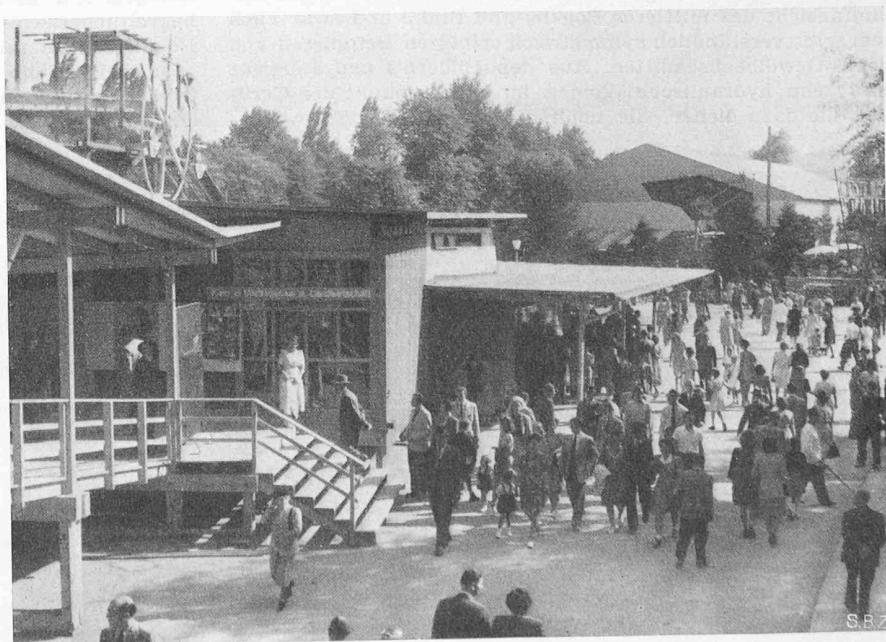
Bild 3. Abteilung Landwirtschaft, links typische Rampenkonstruktion aus genormten Elementen
