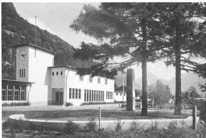
Der Bahnhof Flüelen (Arch. A. Ramseyer) mit dem Denkmal
