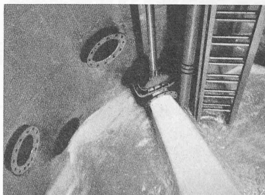
Bild 3. Spülen eines Fassungsrohres
