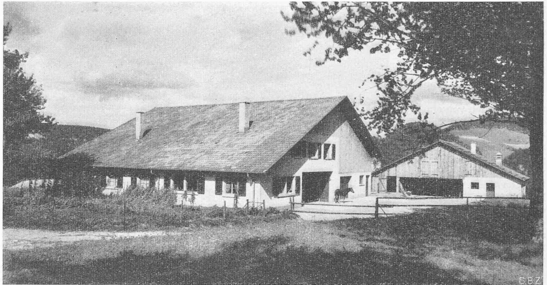
Fig. 1. La ferme au lieu-dit «Les Orties», Soyhières, vue du sud-ouest
