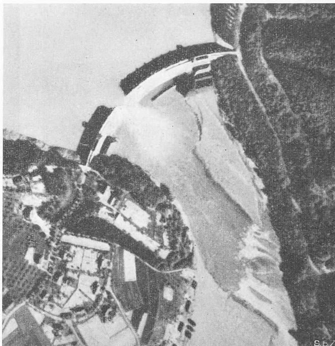
Bild 4. Edertalsperre nach der Zerstörung
