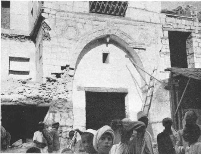
Bild 7. Portal in Jeddah mit überkalkter dekorativer Steinhauerarbeit
