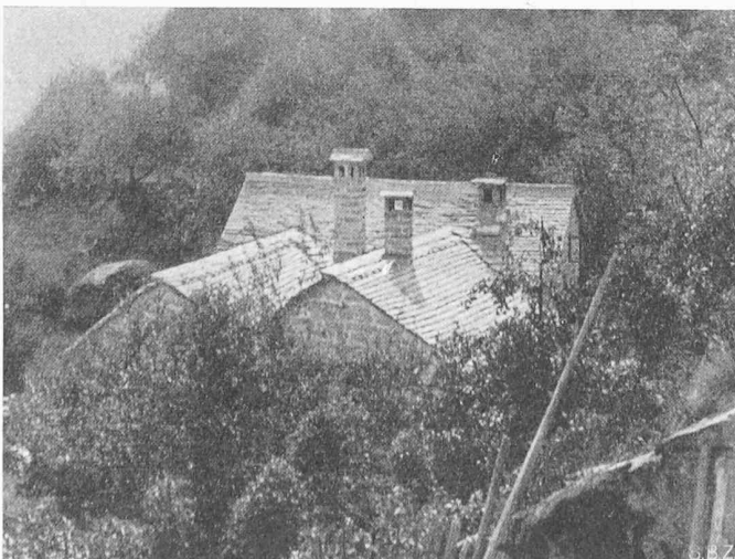
Bild 7. Der Bau aus Osten
