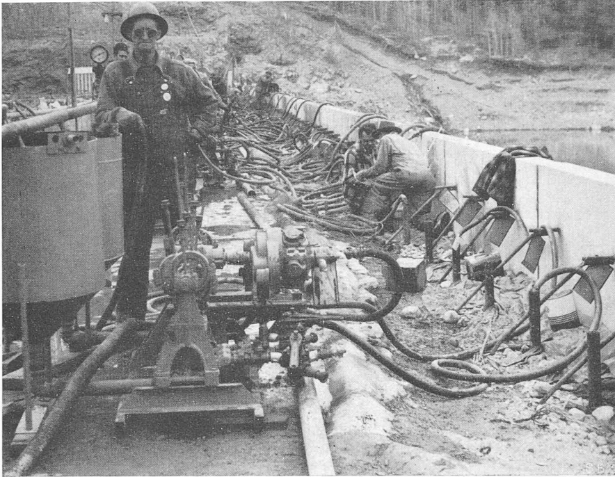
Bild 5. Mauerkrone während des Einfüllens des Mörtels. Links Zwischenbehälter für Mörtel, darüber Mörtelzubringerleitung, daneben Mörtelpumpe mit Druckluftmotor für den Antrieb, darunter Anschlussstutzen für die Schläuche. Rechts: Enden der vertikalen 2" Mörtel-Einfillrohre mit hineingesteckten Schläuchen, dazwischen Inspektionsrohre
