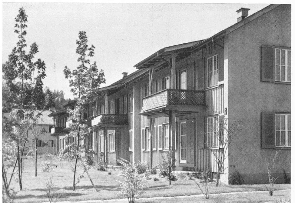
Bild 5. Einzelheiten der Holzbauweise (Stirn- und Brandmauern massiv)
