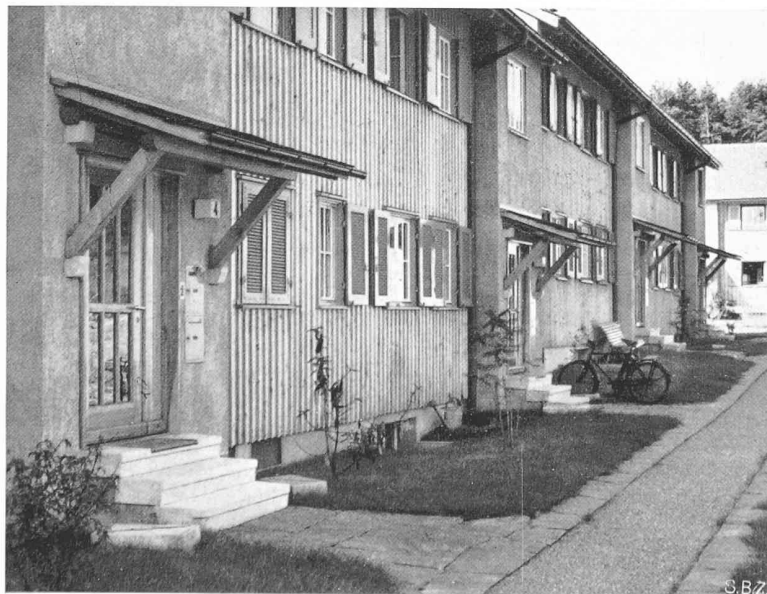
Bild 8. Einzelheiten der Eingangs-Seite (massives Treppenhaus)
