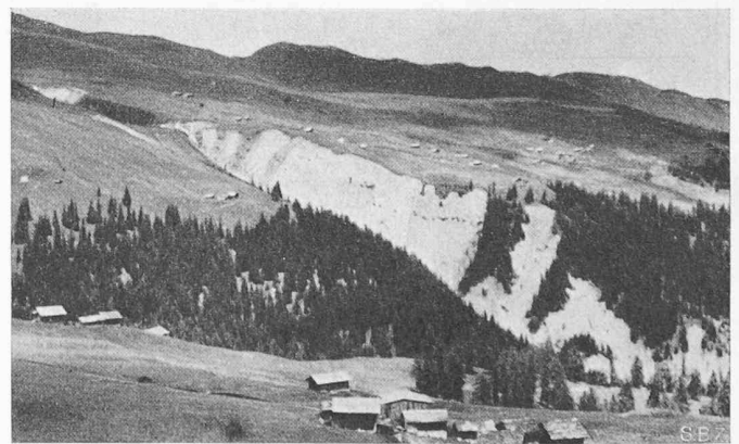
Bild 5. Val Mirèr als oberster Abschnitt des Valtstiel am Schamserberg, von Süden. Tiefe Erosionsrinne in Lokalmoräne und durch Rutschung aufgelockerter Felsunterlage
