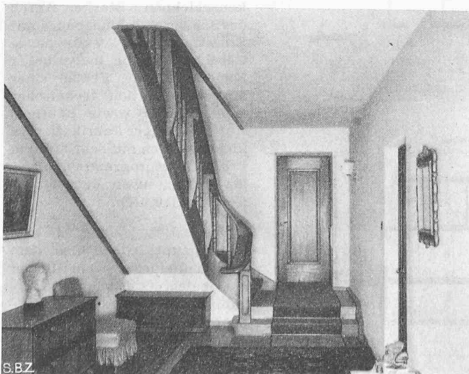
Bild 6. Halle mit Haupttreppe
