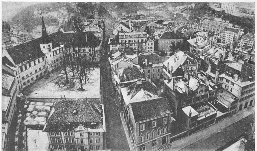
Fig. 1. Vue d'ensemble de la Cité. Ordre à l'ouest, désordre à l'est de la Rue Cité Devant
