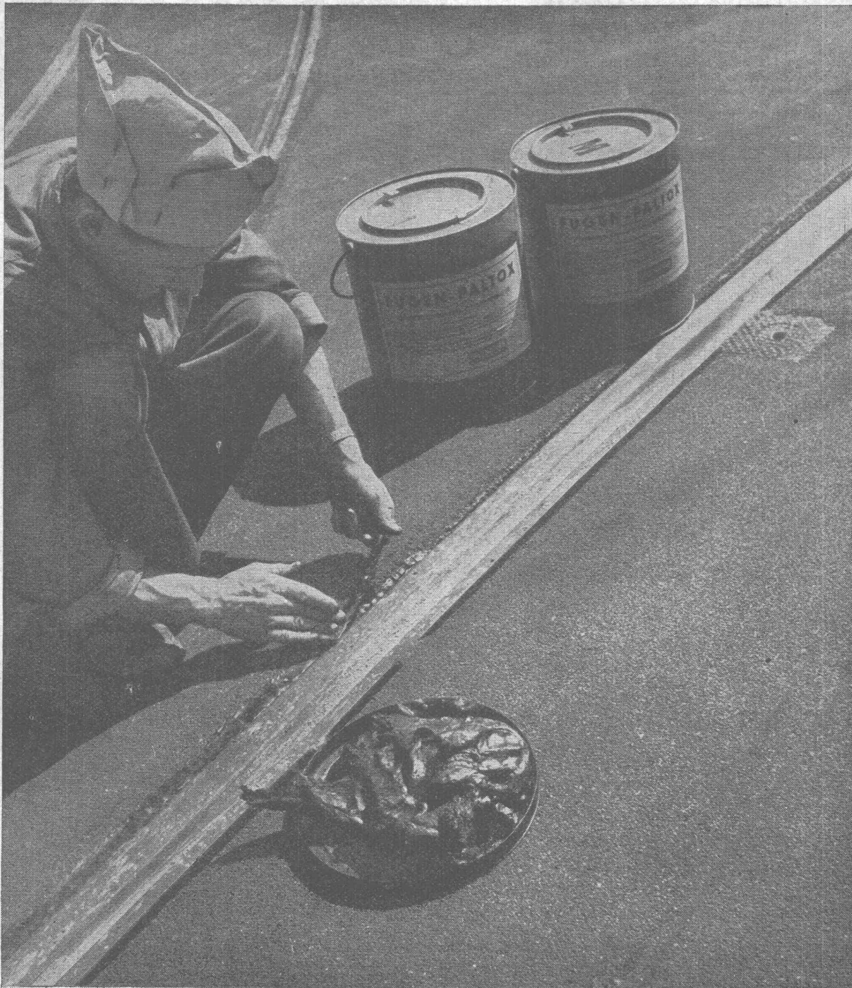
Loose SWB Zürich
