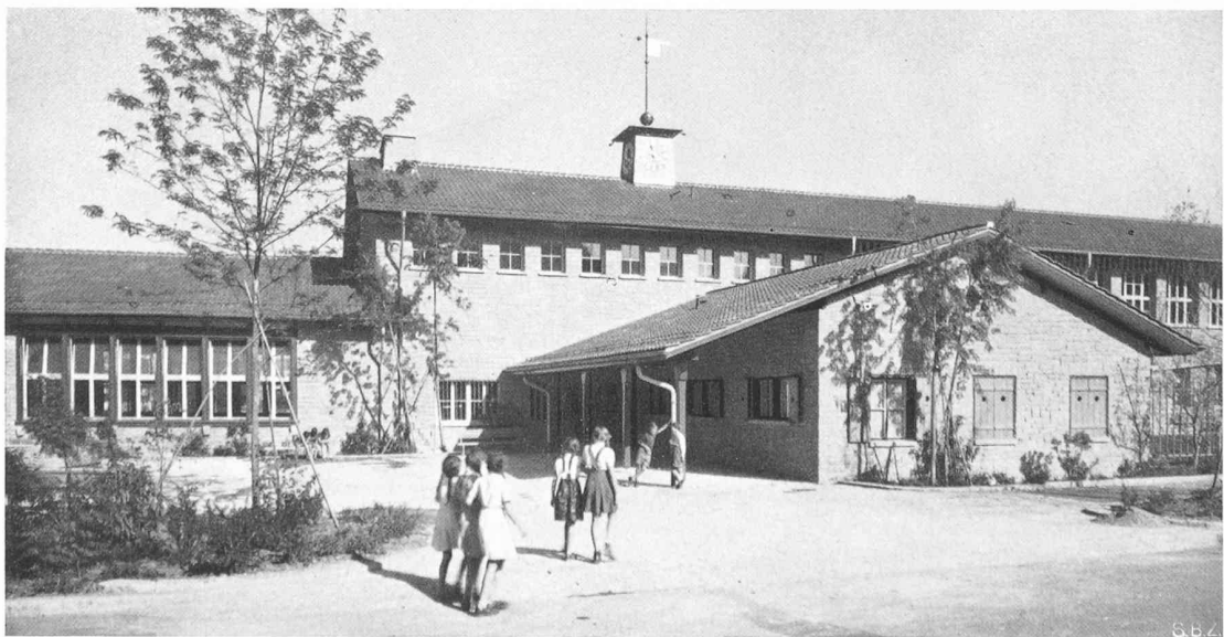
Der Haupteingang aus Nordwesten
