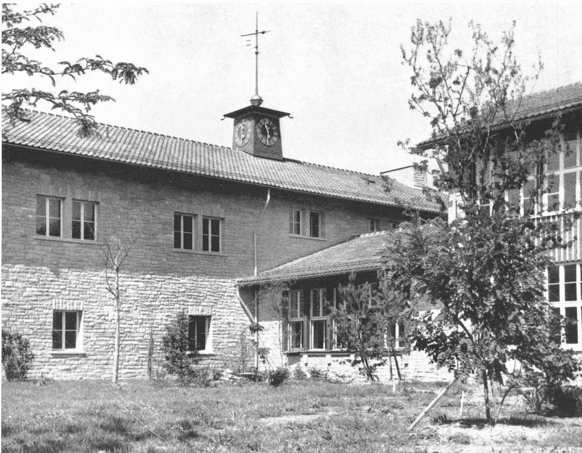
Harmonie von Mauerwerk, Holzwerk, Boden und Vegetation
