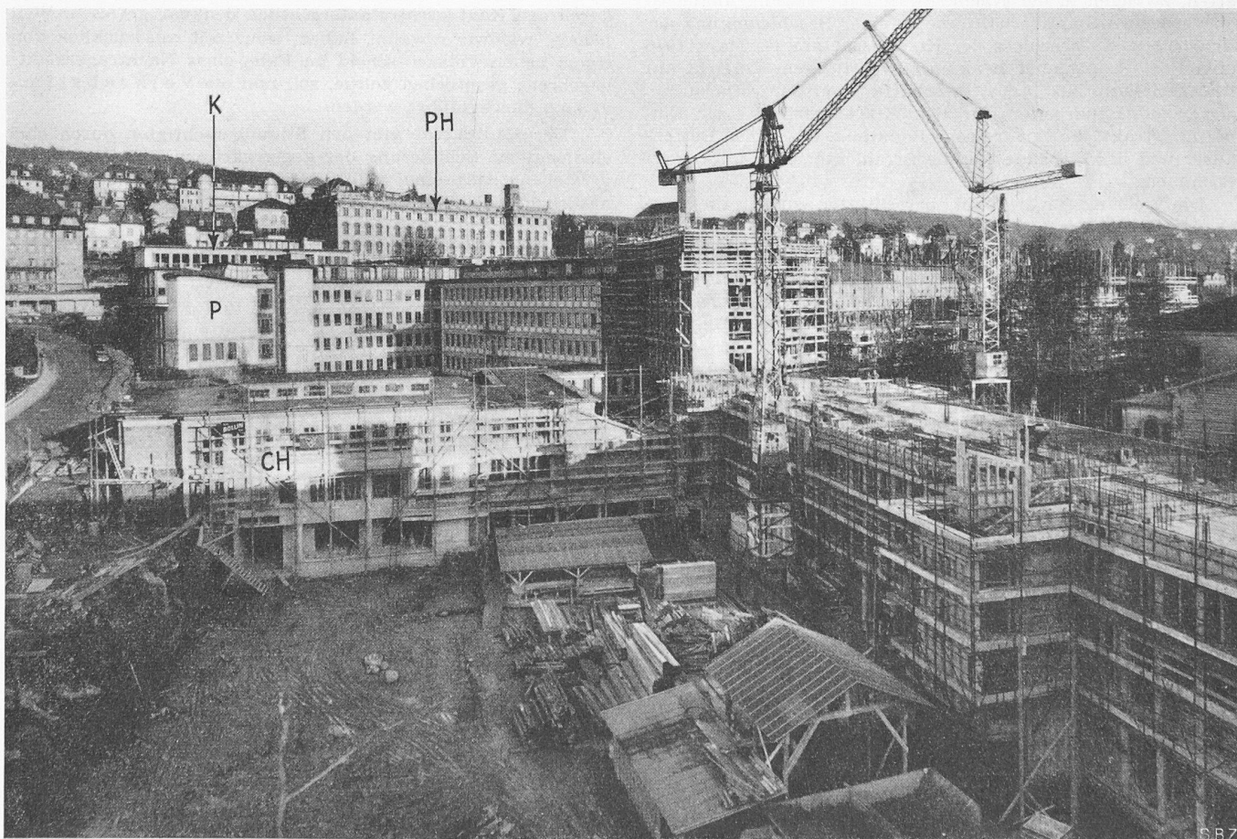
Bild 1. Ein Teil der Baustelle aus Westen. Standpunkt des Photographen: Medizinische Poliklinik, Dach über Geschoss E. Rechts im Hintergrund Bettenhaus Ost, im Vordergrund Bettenhaus West. Ch Chirurgische Poliklinik, P Pathologie, K Küche, Ph Physikgebäude der E. T. H. — Photos Beringer & Pampaluchi, Zürich
