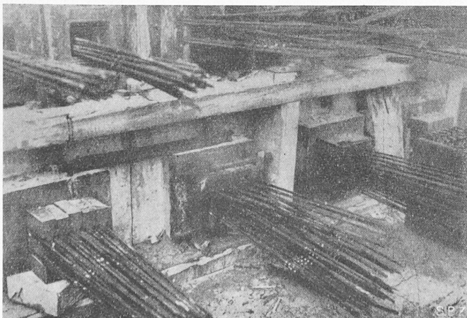
Fig. 4. Abouts des poutres avec câbles
