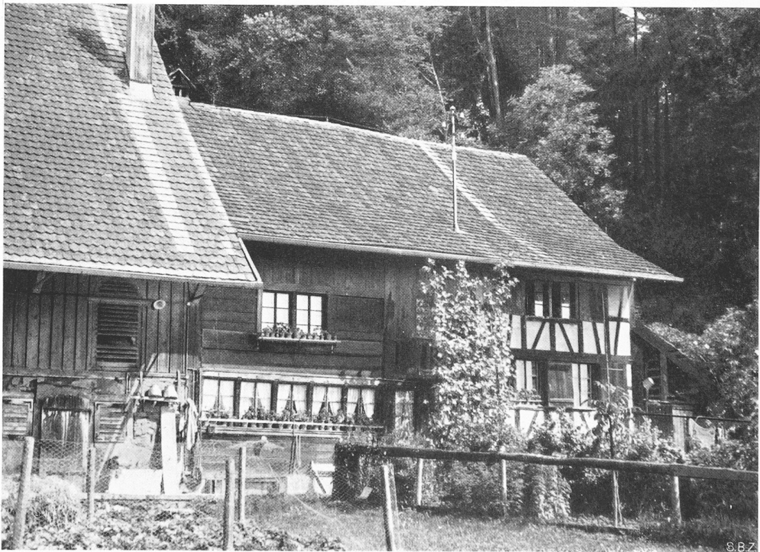
Schweikhof, Gemeinde Hausen am Albis. Kombinerter Riegel- und Blockbau
