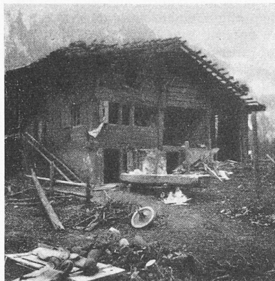
Bild 3. Ein zerstörtes Haus kurz nach der Explosionskatastrophe. Das Holzwerk und die Grundmauern sind mit einer 5 mm dicken Russchicht überzogen, die von den Explosionsgasen herrührt
