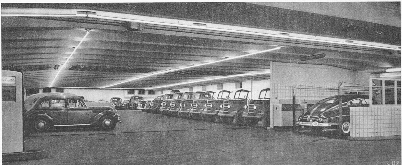
Bild 6. Die mittlere der drei je 17 m weit gespannten und 50 m langen Garagehallen
