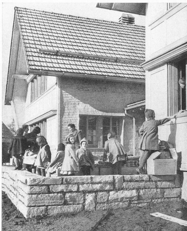
Bild 35. Der Hof vor dem Zürichseehaus
