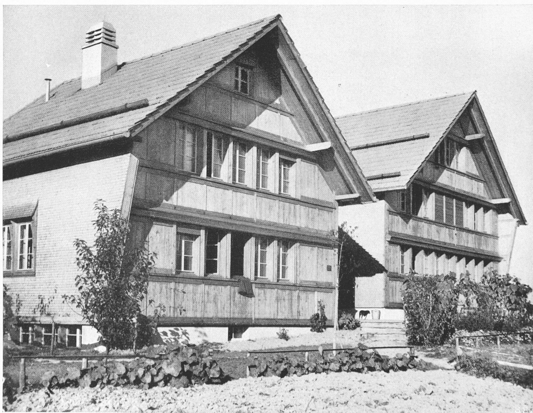
Bild 36. Alle Gärten vor den Häusern wurden von den Bewohnern selber angelegt
