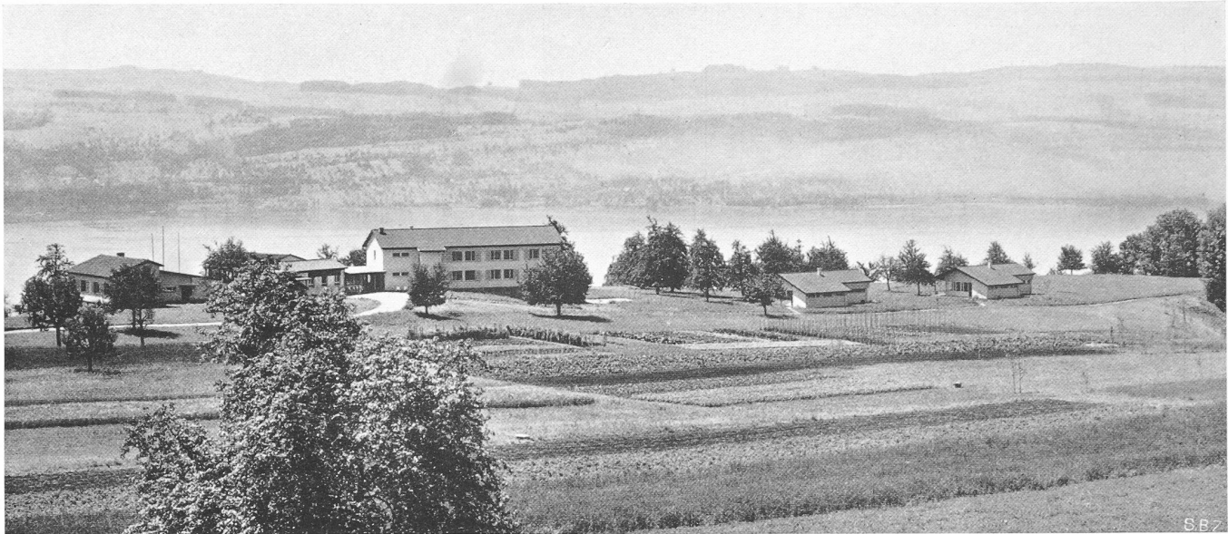
Bild 1. Die reformierte Heimstätte «Boldern» ob Männedorf, 130 m über dem Zürichsee. Gesamtansicht aus Nordosten. Von links nach rechts: Haus des Heimleiters, Haupthaus, Jugendhäuser. Text siehe Seite 10
