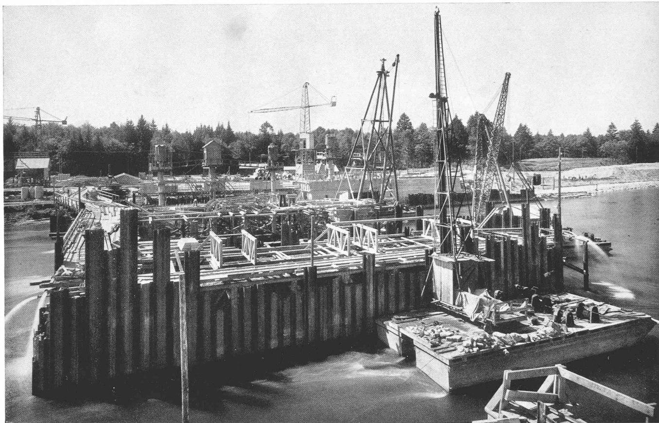
Bild 23. Umspundung für den linken Stauwehrpfeiler. Aufnahme 24. August 1943 vom linken Ufer aus
