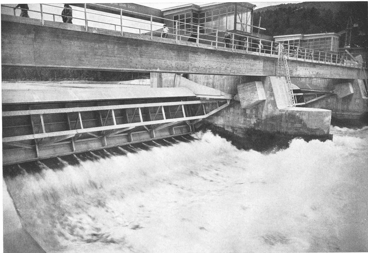
Bild 20. Stauwehr. Sektorhakenschütze der rechten Wehrröffnung
