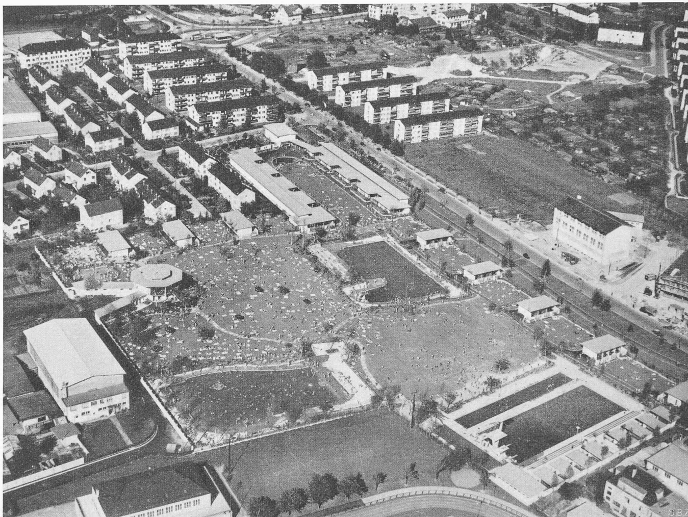
Bild 1. Gesamtanlage aus Südwesten. Zur Orientierung: im Hintergrund die Tramhaltestelle Letziggraben in der Badenerstrasse
