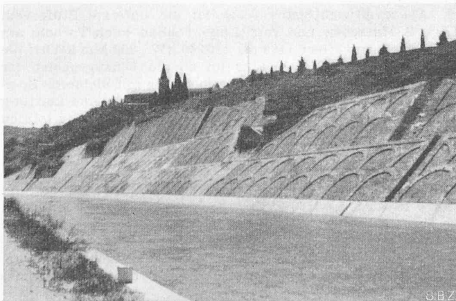
Bild 30. Kraftwerke Medio Adige: Kanalstrecke Ala-Bussolengo mit Hangverbauungen
