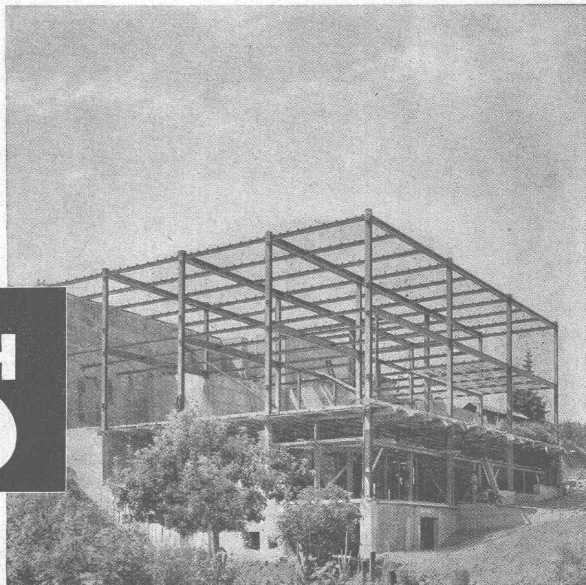
Stahlskelett für Fabrikgebäude
