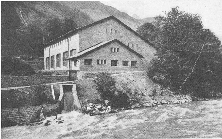
Bild 9. Aletschwerk, Maschinenhaus von der Rhone aus gesehen
