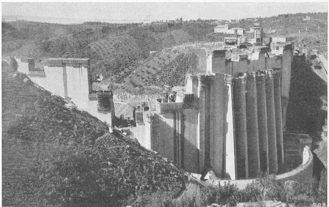
Bild 1. Stau-mauer Castelo do Bode, Portugal, am 25. Febr. 1950. Die Wasserseite wird gebildet durch einen 300 \text{ m} weit gespannten Vertikal-Zylinder, r = 150 \text{ m} , mit über 100 \text{ m} freier Höhe. Die vorgebauten Rechenbahnen, an deren Fuss die Rechen vor den drei Wasserfassungen liegen, haben die Höhe erreicht, wo die Aufbauten für Revision und Bedienung von Rechen und Schützen ansetzen. Beidseitig der Wasserfassungen liegen die Grundablässe, darüber deren Schützen-Bahnen. In den Bahnen sind die Belüftungen der Einläufe untergebracht. Die Einläufe bleiben geschützt durch die Gewölbemauer des Fangdammes. Die Stau-mauer hat in den obersten Blöcken die volle Höhe erreicht; der Hochwasserüberfall in Eisenbeton folgt nach
